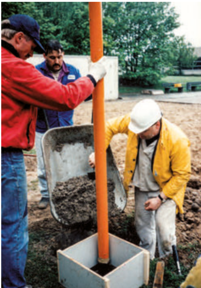
Aushub für das Fundament des Netzpfeostens (Bild oben). Der Netzpfeosten muss senkrecht stehen. Hermann Onken, Nico Herz und Peter Wendtland geben sich Mühe (Bild unten links). Rainer Bohn und Borge Golombek setzen einen Kantstein (Bild unten rechts).
