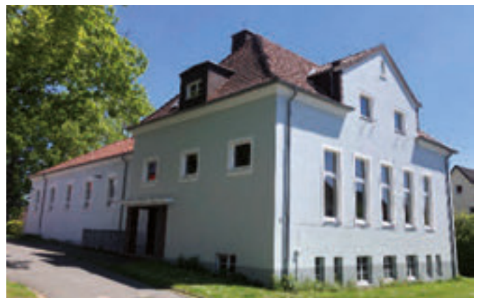
Die renovierte Halle hat sich zu einem „Schmuckkästchen“ gemauert.
